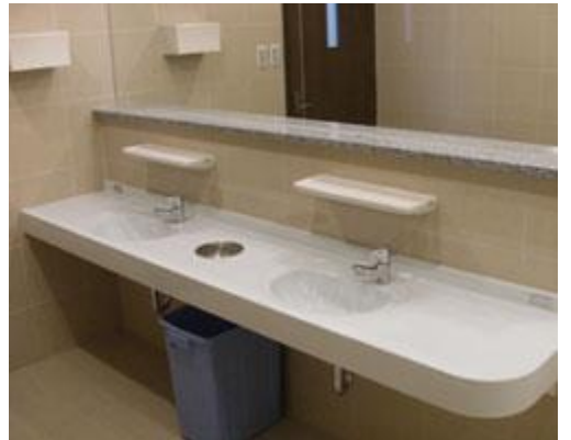
尚学院(丸三名護)トイレ改修工事 着工後
