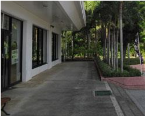
▲ペンション美留外壁塗替 着工前
