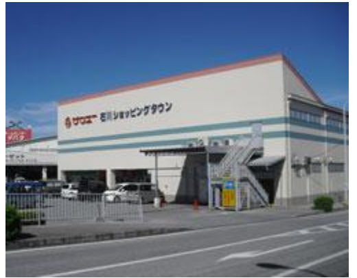
▲石川ショッピングタウン外壁塗替え 着工後
