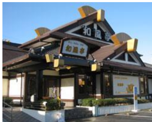
▲和風亭小祿店リニューアル工事 着工後
