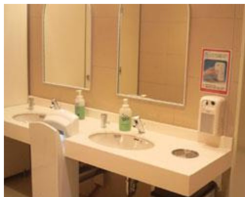
▲ハンビータウン北側トイレ工事 着工後
