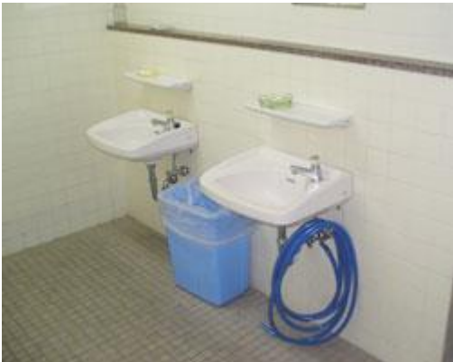
▲尚学院(丸三名護)トイレ改修工事 着工前
