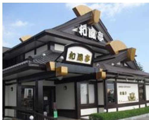
▲和風亭為又店リニューアル工事 着工後
