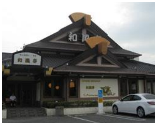
▲和風亭小祿店リニューアル工事 着工前
