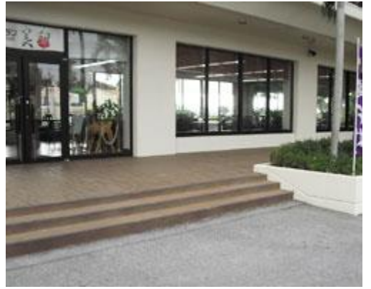
▲ペンション美留外壁塗替 着工後
