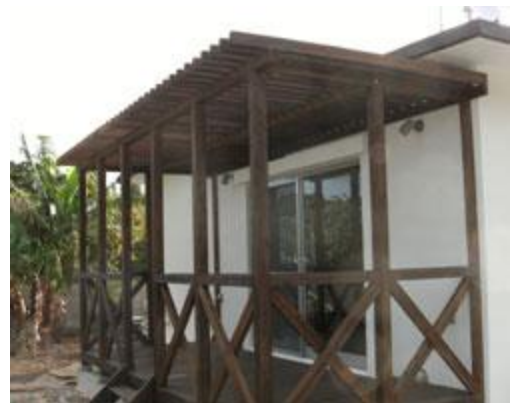
▲S邸工事 着工後
