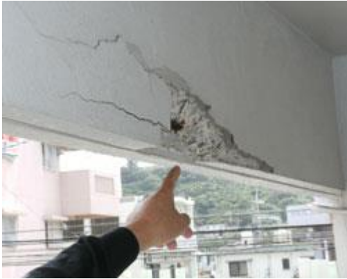
▲和風亭小祿店リニューアル工事 着工前
