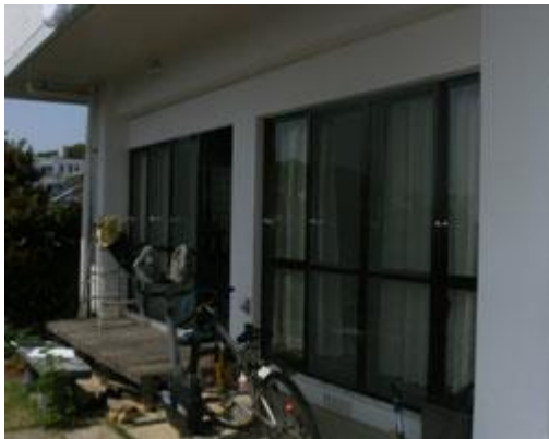
▲首里グランドM邸工事 着工前
