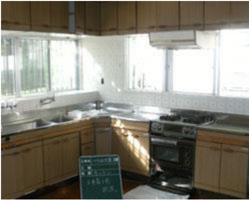
▲K邸工事 着工前
