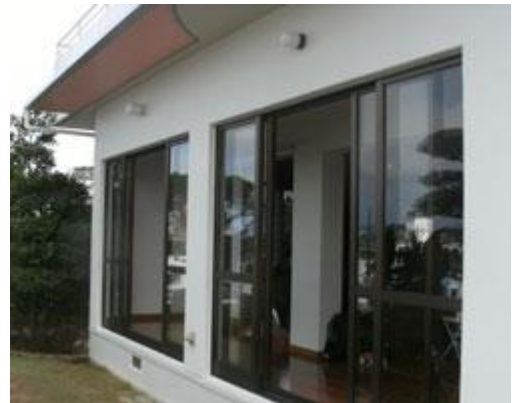
▲首里グランドM邸工事 着工後
