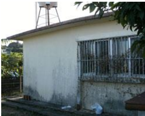
▲S邸工事 着工前
