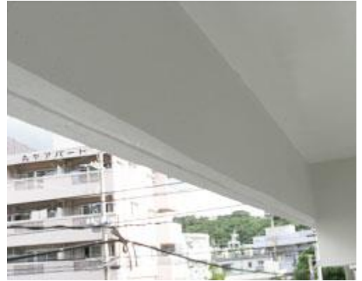
▲和風亭小祿店リニューアル工事 着工後
